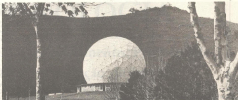
No Rádio-Observatório do Itapetinga, a redoma de plástico de 23 m encerra uma antena de precisão de 14m, única do gênero no hemisfério sul e uma das melhores do mundo.
